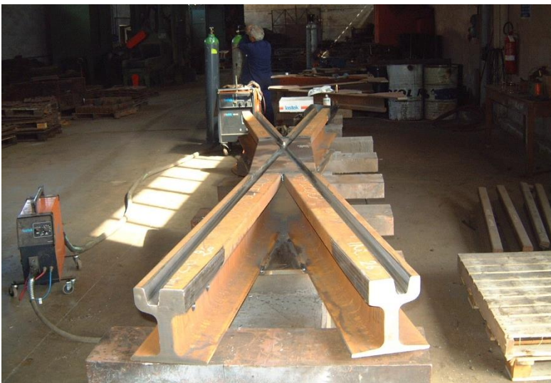
VISTA DI INCROCIO TRANVIARIO IN FASE DI LAVORAZIONE (sinistra)
